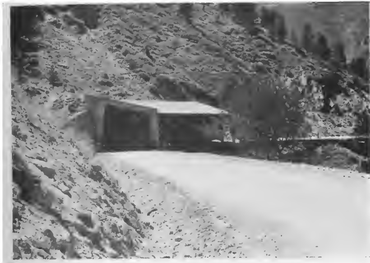
FIG. 15. — Tunnel anti-neige à Zigana.
